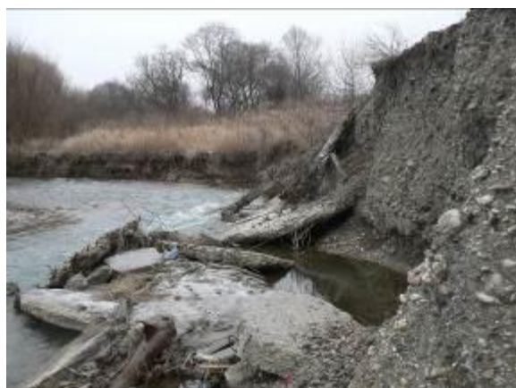
Рис.2. Разрушение рекой дамбы Новопятигорского озера. 2007г.
